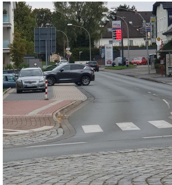
Abbildung 6: Kopfsteinpflasterung im Kurvenbereich (links) sowie Parkflächen hinter dem Gehweg (rechts)
