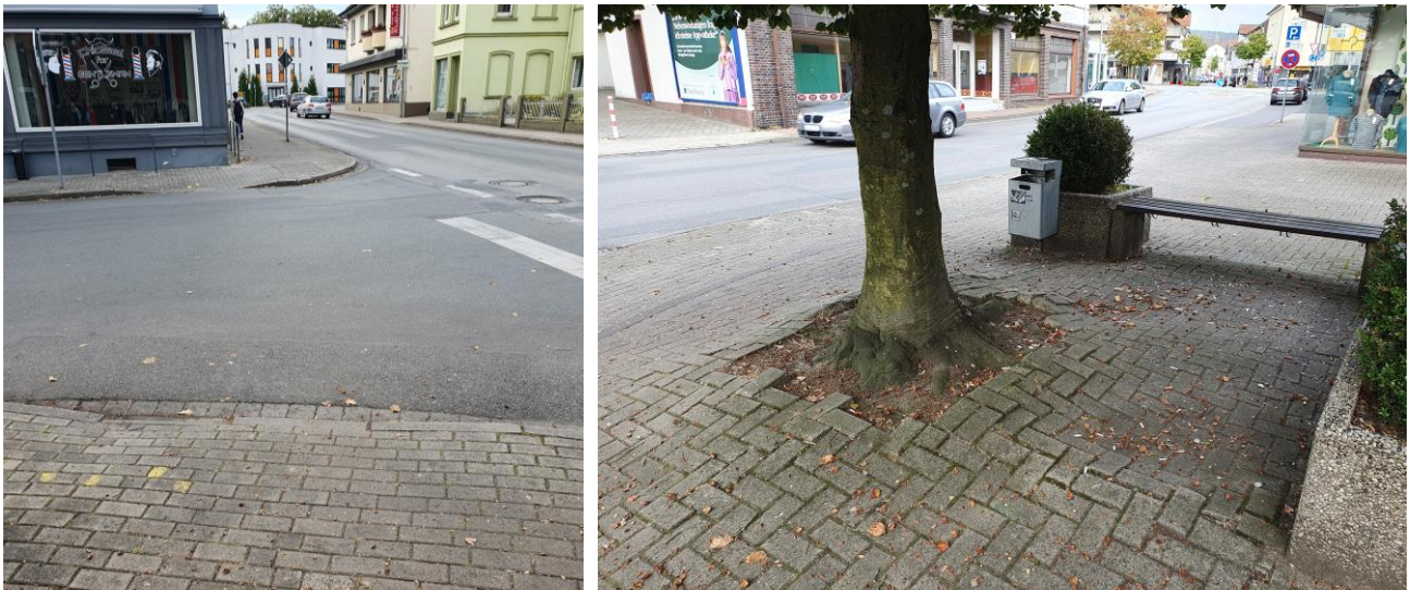
Abbildung 9: Querungssituation über die Südstraße (links) sowie Zustand des Gehweges vor dem Geschäft „Moden Borghaus“ (rechts)
