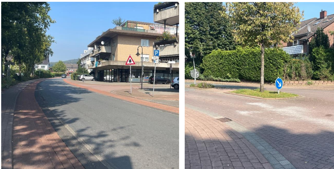
Abbildung 8: Kreuzungsbereich Dieckmannstraße/Scheerenhof (links) und Querungshilfe an der Einmündung zur Bergstraße (rechts)
